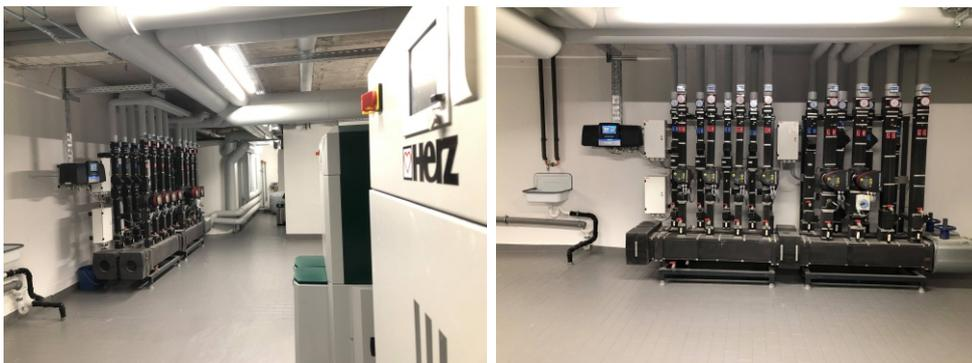
Wir durften im Rathaus der Gemeinde Wilnsdorf die Heizungsanlage erneuern. Die alte Gas-Heizungsanlage wurde gegen eine neue CO<sub>2</sub>-neutrale Pelletanlage ausgetauscht. In diesem Zuge wurde auch der hydraulische Abgleich sowie im Mehrzweckraum die Lüftungsanlage erneuert.
